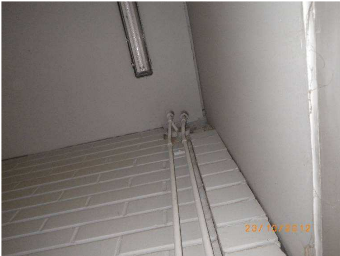
Kuva 4. Putkiläpiviennit maalaamon puolelle
