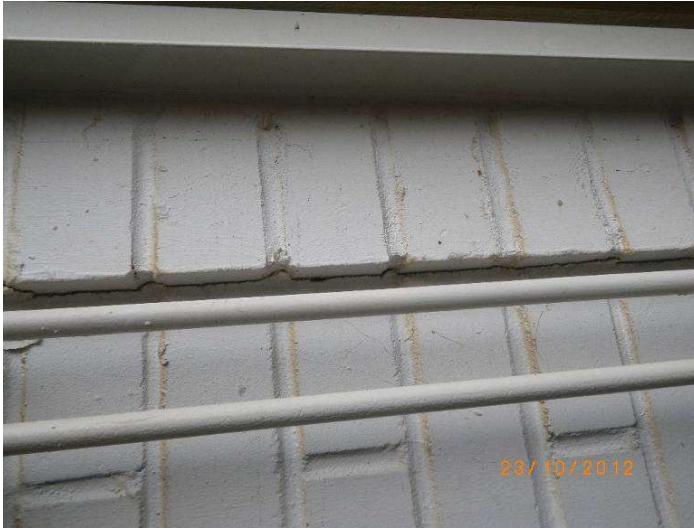
Kuva 3. Tiiliseinäessä rakoilua
