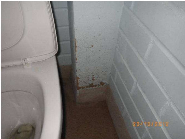
Kuva 6. Putkikotelo turvonnut
